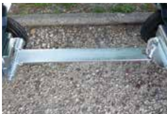
Unión entre contenedores
